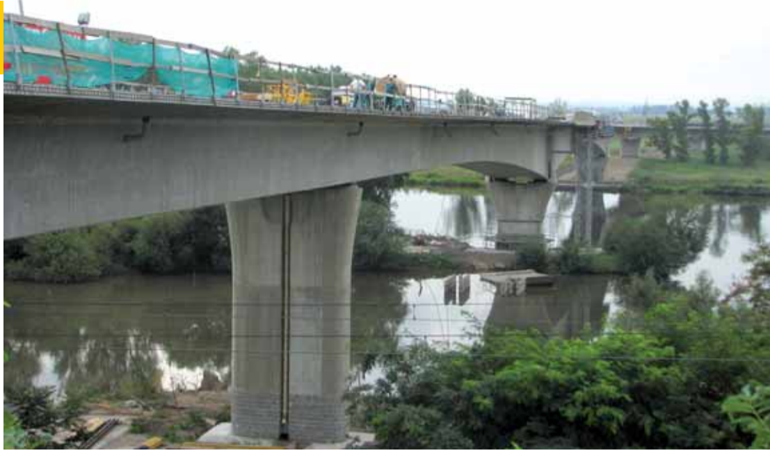
Nový most přes Labe v Litoměřicích je doslova srdeční záležitostí Ing. Jiřího Šulce. Ten, když byl ještě hejtmanem Ústeckého kraje, jeho stavbu prosadil a nyní jako radní dohlíží na jeho dokončení.
