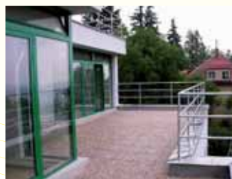
Rekonstrukce vily Praha.
