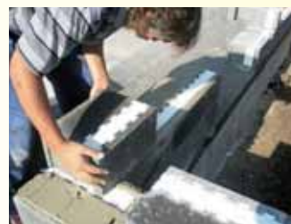
Výstavba rodinného domu.
