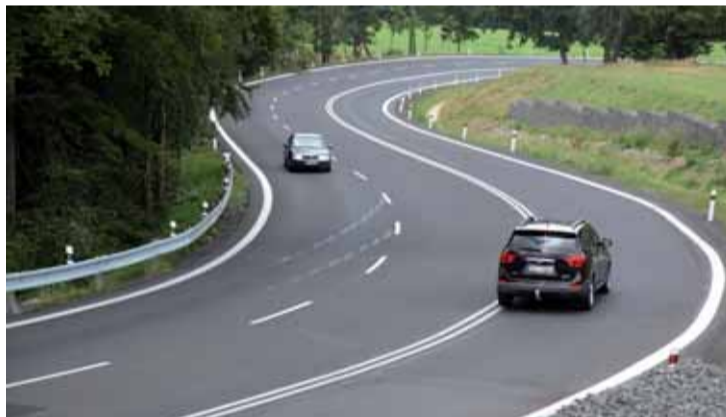
Pohled na část nové komunikace se stoupacím pruhem nad obcí Líska.
