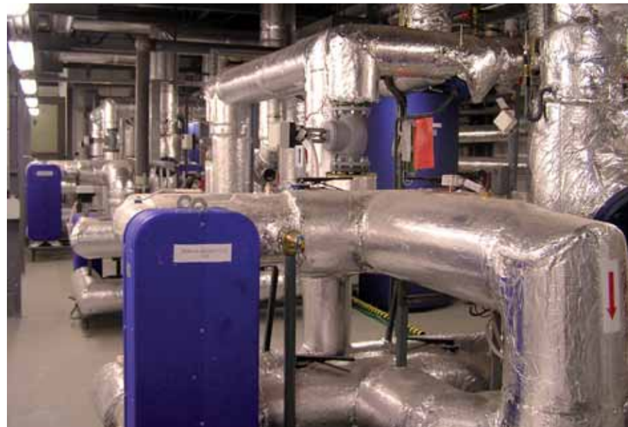
Pohled do zrekonstruované výměňkové stanice VS 21 v ulici Vítězslava Nezvala.
