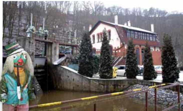
Zimní pohled na malou vodní elektrárnu Želina s jejím maskotem.
