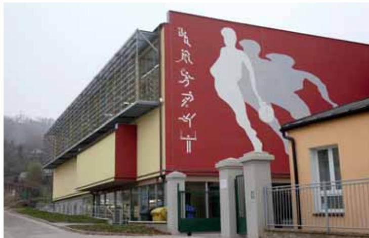
Zhotovitelem stavby bylo sdružení EDS holding, a.s. a AZ Sanace.
