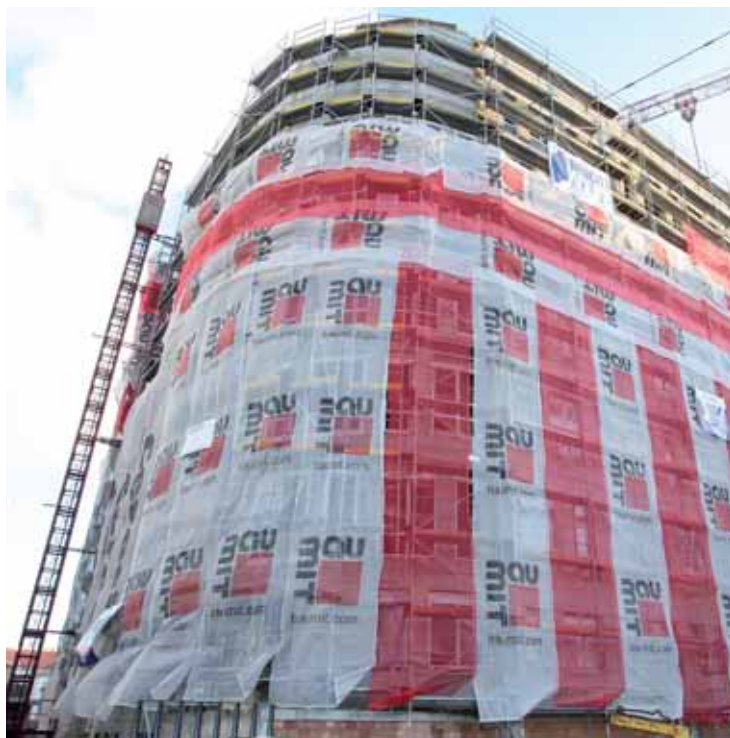
V celé budově není ani jeden pravý úhel.
