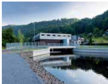
Vodní elektrárna v Železném Brodě.
