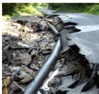
Prioritou jsou opravy a rekonstrukce poškozených vodovodních sítí, na snímku přívadec pro Hřensko.
