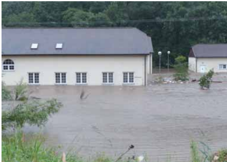
Na Liberecku byla povodní nejvíce poškozena čistírna odpadních vod v Chrastavě.
