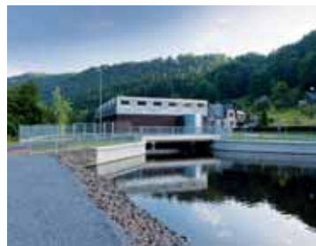
Vodní elektrárna v Železném Brodě.
