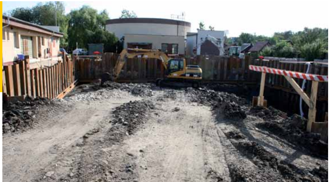
Probíhající rekonstrukce čistírny odpadních vod v Podbořanech.
